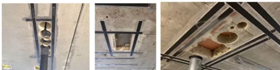
Exemples de renforts par plats carbone autour de percements en plancher
